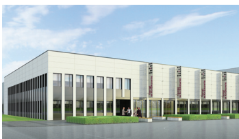
Fot. N C Architektki i 9780 Architektki
